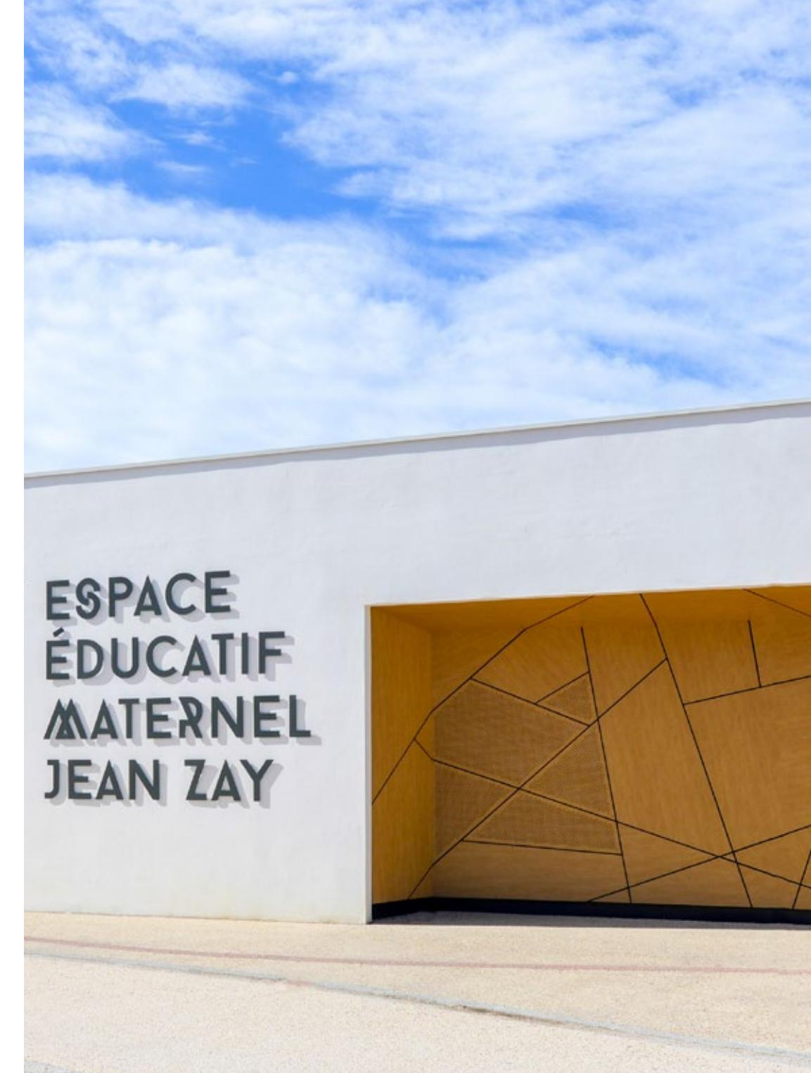
**ITA** Non ci sono limiti alla forma nei progetti di architettura contemporanea. MEG, Material Exterior Grade, è il materiale messo a punto da Abet Laminati per consentire la massima libertà di applicazione in verticale. MEG è indicato per facciate continue, uniformi, colorate, personalizzate o ancora geometricamente sagomate grazie alla produzione di pannelli tagliati ad hoc. MEG è la soluzione ideale per le facciate ventilate e la produzione di arredo urbano e segnaletica in generale.
